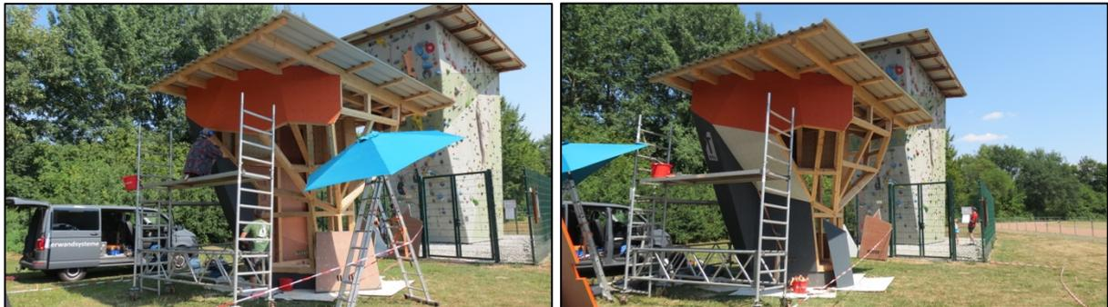
Die Unterkonstruktion, auf der die Kletterplatten montiert sind, besteht übrigens aus insgesamt 128 verschiedenen Holzbauteilen, mit einer Gesamtlänge von rd. 220 Metern und einem Gewicht von 1,2 Tonnen.
